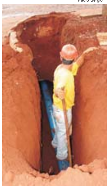
Esgoto: Com a autarquização o Sistema de Esgoto poderá ser resolvido
