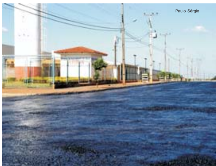
Reservatório Vitória um dos empreendimentos do DAE na atual administração
